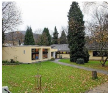
Anbau und Renovierungen in den Folgejahren
